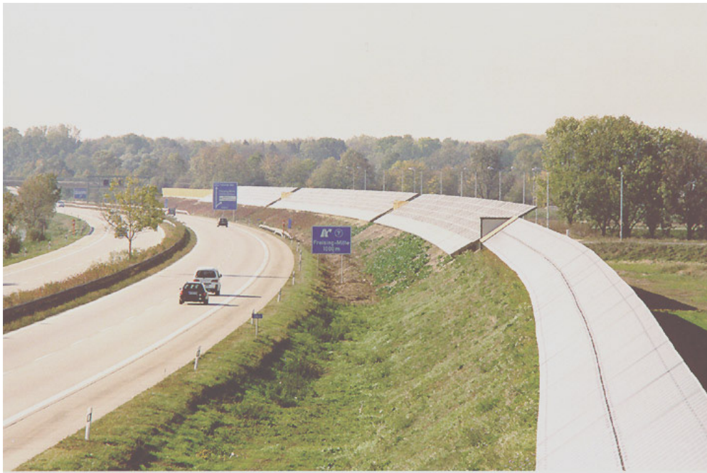
Figuur 2.3 Grootste project van geluidsschermen (499 kW) ligt langs de A92 bij Freising in Duitsland
