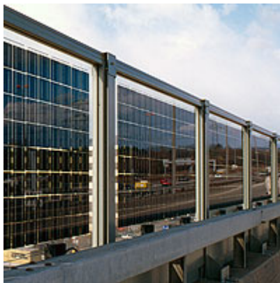
Figuur 2.4 Toepassing van dubbelzijdige zonnecellen in middenberm
